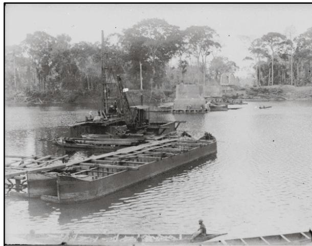
*Figure 57-des radeaux pour le pont sur la Sanaga*
